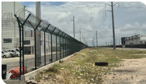
Vallado perimetral de malla cfareja (acero de alta resistencia) y alambre navaja concertina en su parte superior
