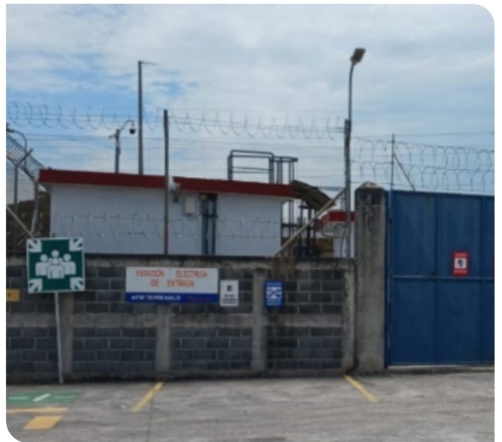
Zona restringida identificada, señalizada con los riesgos asociados, con videovigilancia y alumbrado eléctrico tipo LED -APM Terminals Quetzal-.
