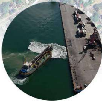
Dragado de hasta 11 metros de profundidad en los 4 atracaderos
